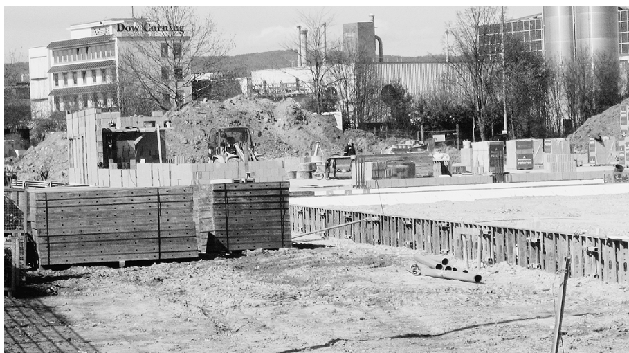
Eingesetzt wurden in Wiesbaden vorwiegend Rasto-Tafeln mit einer Elementhöhe von 2,70 m.
