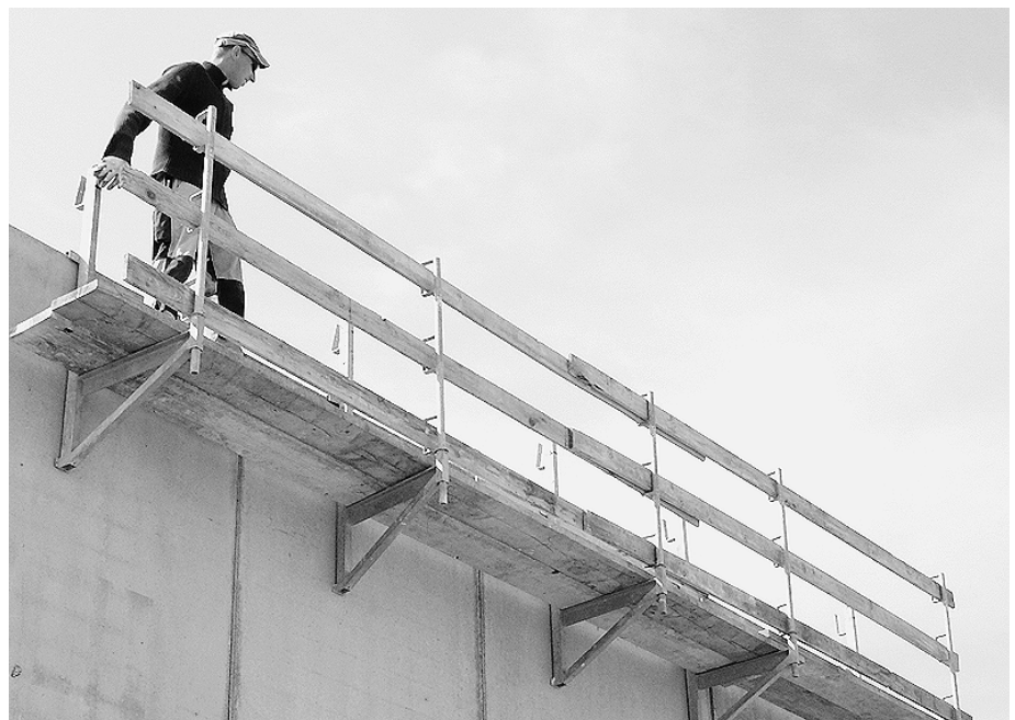
Die Hohlwand-Betonierkonsole wird mit dem Einhängedorn an beliebiger Stelle in den Zwischenraum der Elementwand eingehängt.
