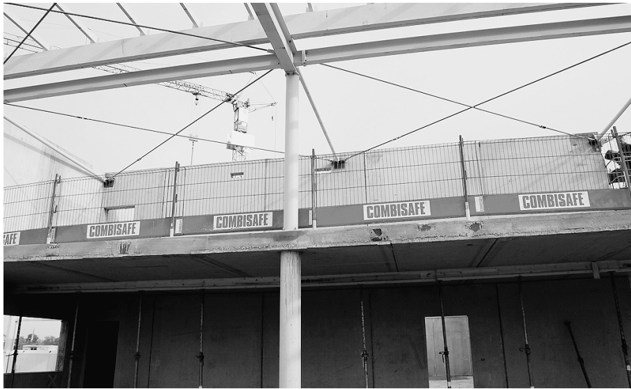
Die Basis des modularen Absturzschutzsystems bildet der Pfosten in Kombination mit dem Stahlgitter. Entsprechend der konkreten Baustellensituation wird dann die entsprechende Sockelbefestigung ausgewählt. Fotos: Lerch
