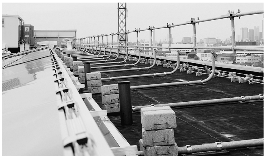
Mit dem Flachdachabsturzsicherungssystem der Firma Lerch kann bei allen Arbeiten auf Flachdächern, beispielsweise Rekonstruktionsarbeiten, Abdichtungsarbeiten, Dachklempnerarbeiten und Montagearbeiten, ein kollektiver Seitenschutz gegen Absturz gewährleistet werden.
